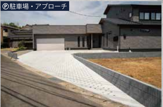
施工：熊本県 株式会社オオマス様
