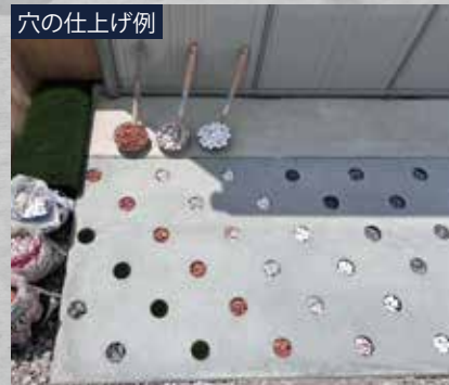
施工：埼玉県 芦谷工業様
