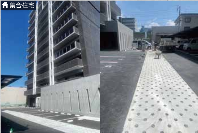
施工：熊本県 ヤマエ BUILD 株式会社様
